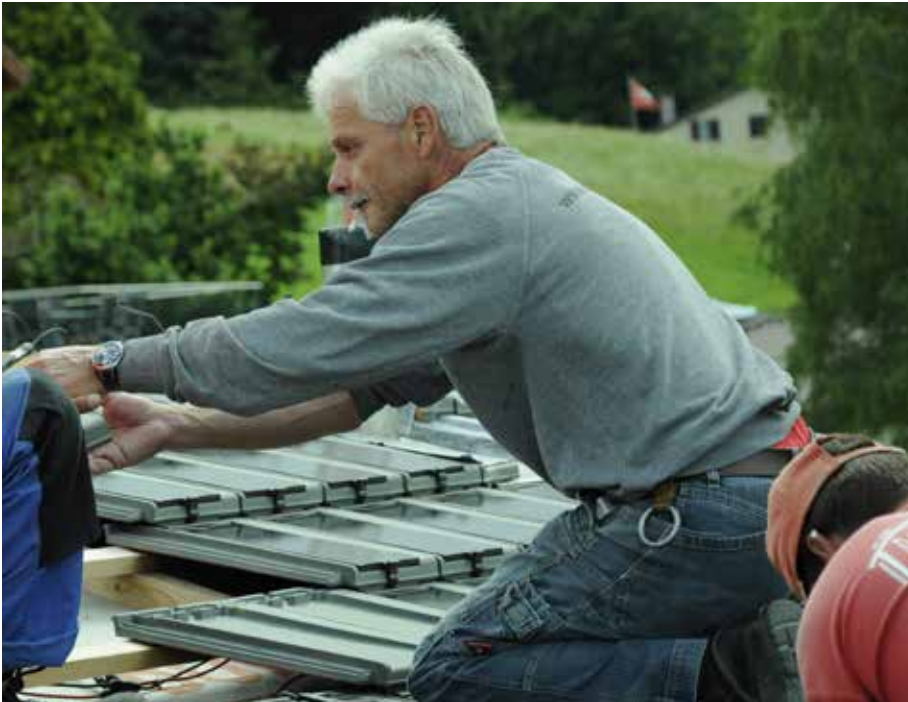
Innerhalb von drei Arbeitstagen wurde das System installiert.
