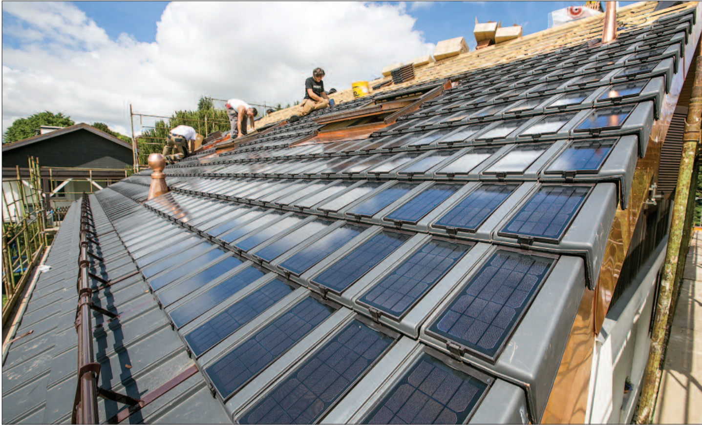
René Morel a opté pour la pose de tuiles photovoltaïques, plus discrètes que les panneaux solaires. CLAUDE HAYMOZ
