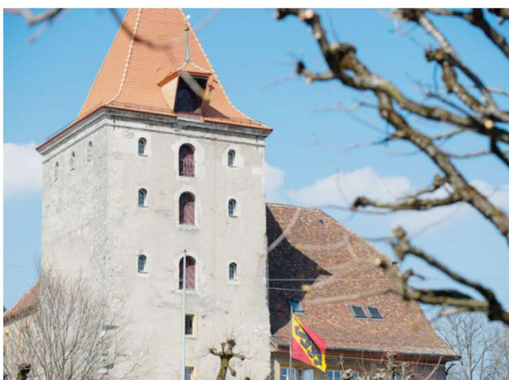
Die neuen Ziegel links leuchten hellrot und passen nicht so recht zu den alten rechts. PETER SAMUEL JAGGI
