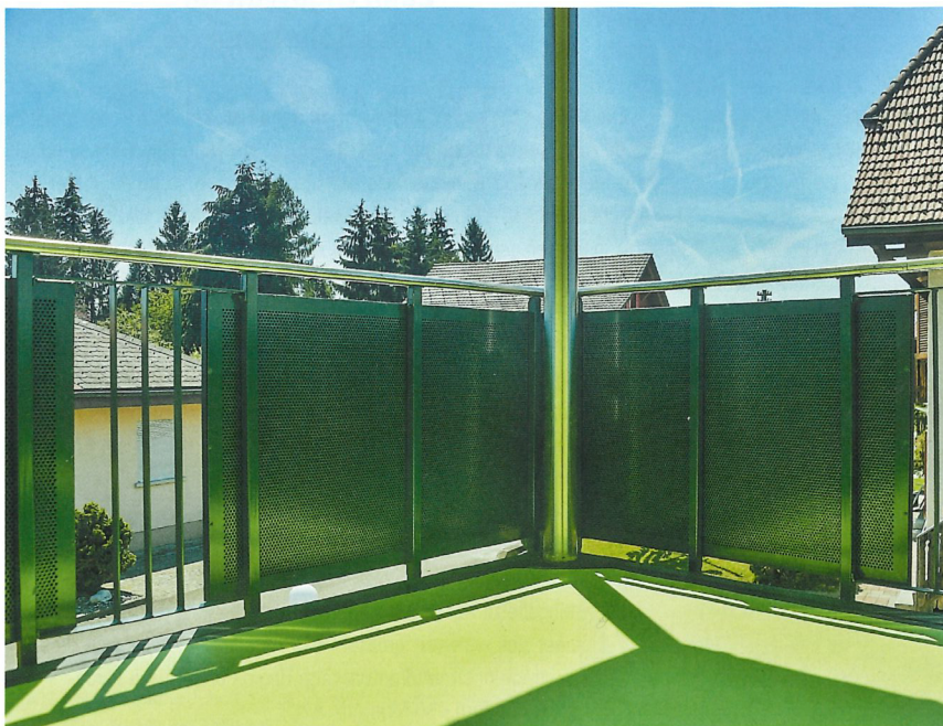
Kein Farbstich, sondern gewollte Kombination vor den Balkonmodulen: Aufgrund einer speziellen Farbmischung erscheinen die Terrassen und die Süd-West-Fassade je nach Sonneneinstrahlung gelbgrün
