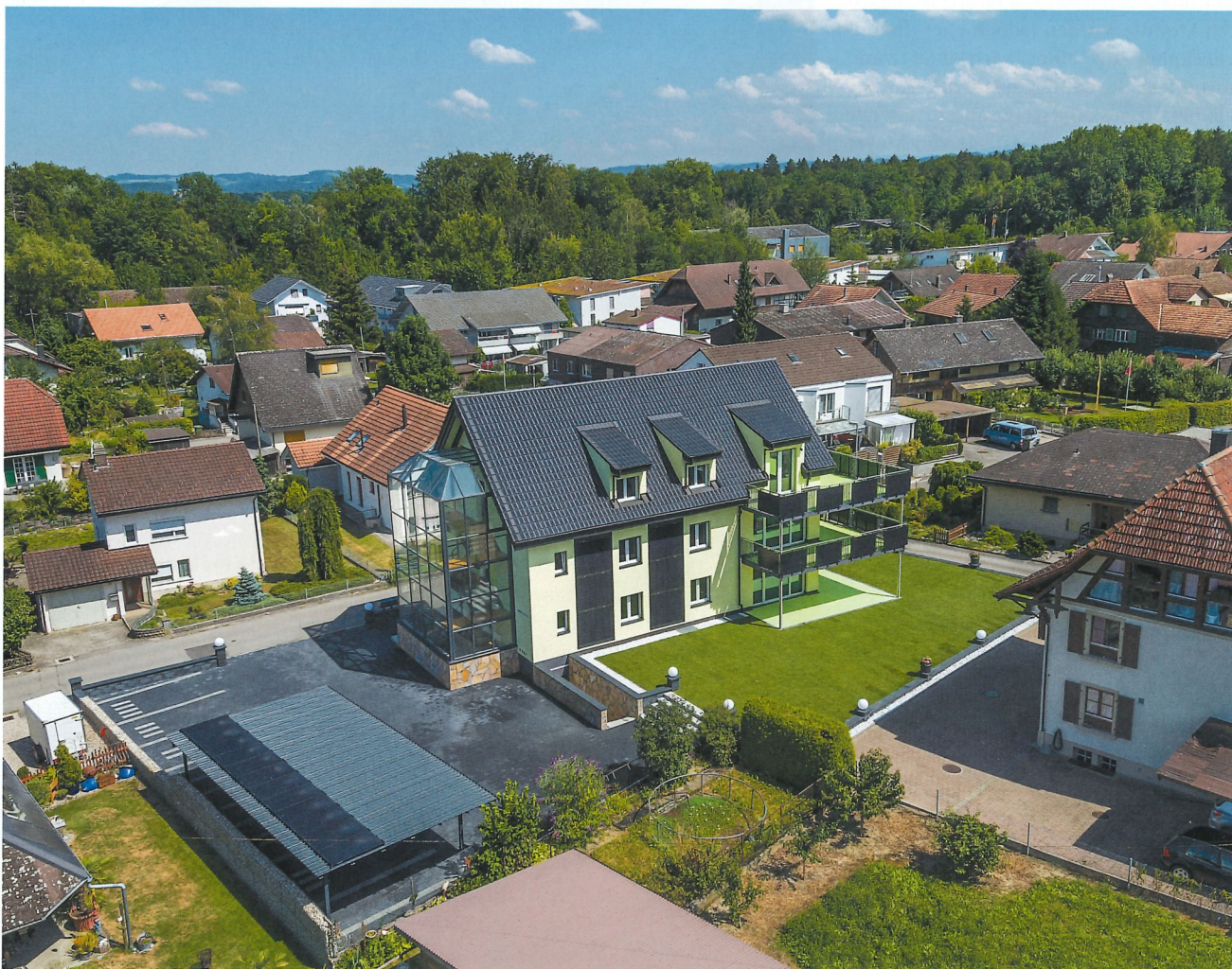
Balkon, Carport, Dach, Fassade: 375 Quadratmeter werden zur Solarstromgewinnung genutzt
