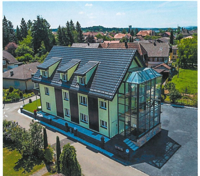
Die 6,2 Kilowatt leistende Fassadenanlage wurde in drei Streifen senkrecht installiert
