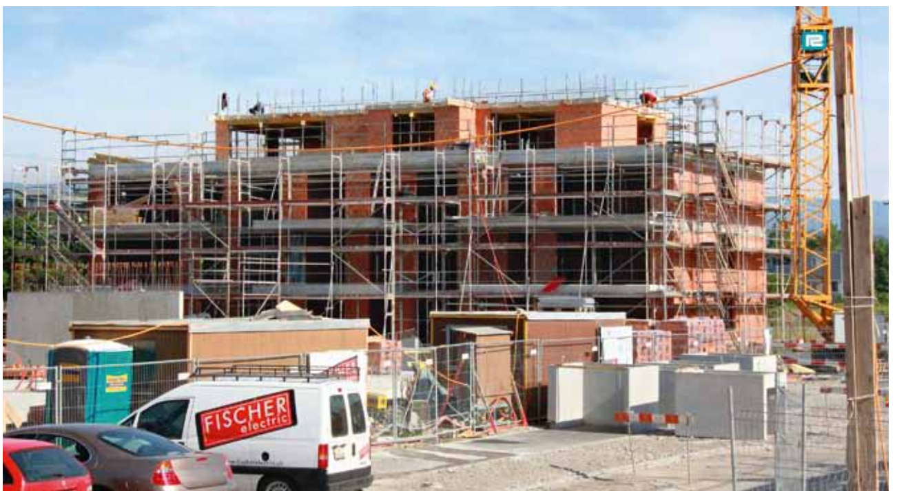
Rohbau im Mai 2015
